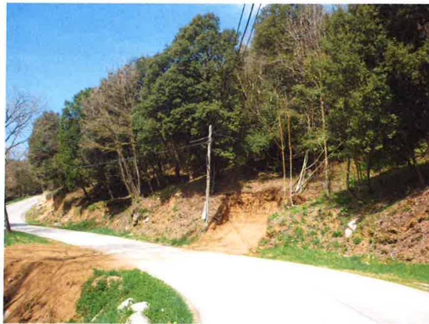
Imatge 14.1.- Pal de fusta de la línia telefònica aèria situat a l'altre costat del carrer: l'hi arriba una línia i en marxen dues seguint dues direccions diferents.
