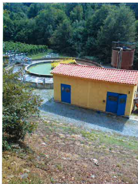
Imatge 9.1.- Estació depuradora d'aigües residuals de Viladrau.
