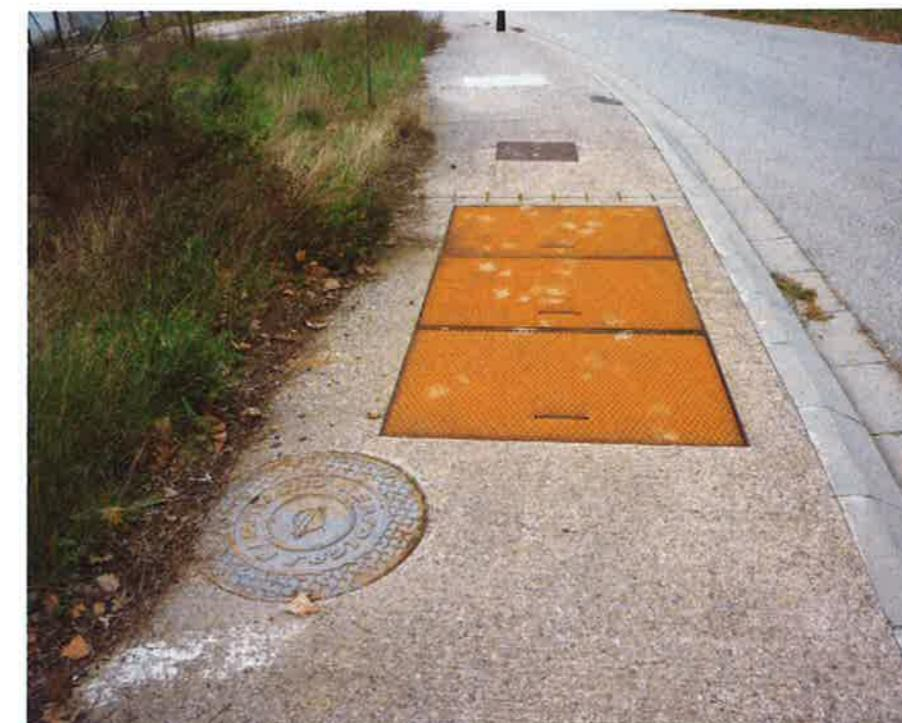
Foto número 15 Arquetes de diferents serveis a respectar sobre vorera del carrer de dalt. Vorada remuntable prefabricada de formigó amb rigola blanca a mantenir.
