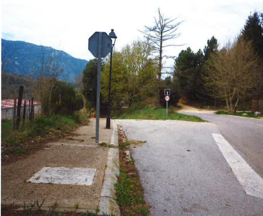
Foto número 13: Enllaç carrer de dalt amb la carretera GI-520. Vorera de formigó a respectar de 1,50 metres d'amplada; en aquesta s'hi observa una arqueta de telefònica i un fanal tipus vuitcentista a respectar.
