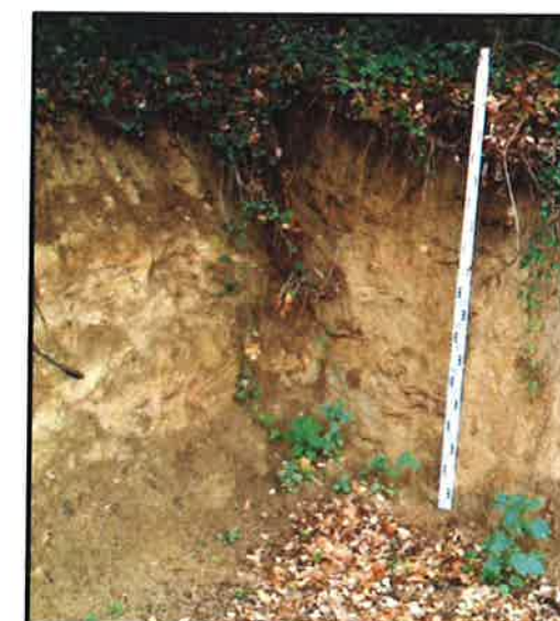
Detall d'alguns afloraments dels materials de la capa A 1 . Visualment conserven l'estructura de la roca granítica, però es poden excavar fàcilment i es desgranen superficialment en forma de sorres.
