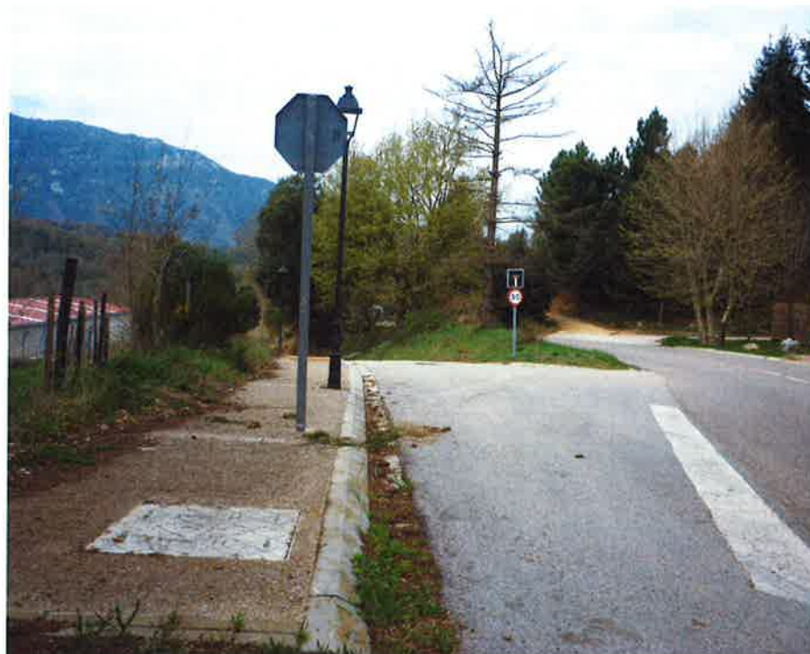
Foto número 13: Enllaç carrer de dalt amb la carretera GI-520. Voreta de formigó a respectar de 1,50 metres d'amplada; en aquesta s'hi observa una arqueta de telefònica i un fanal tipus vuitcentista a respectar.
