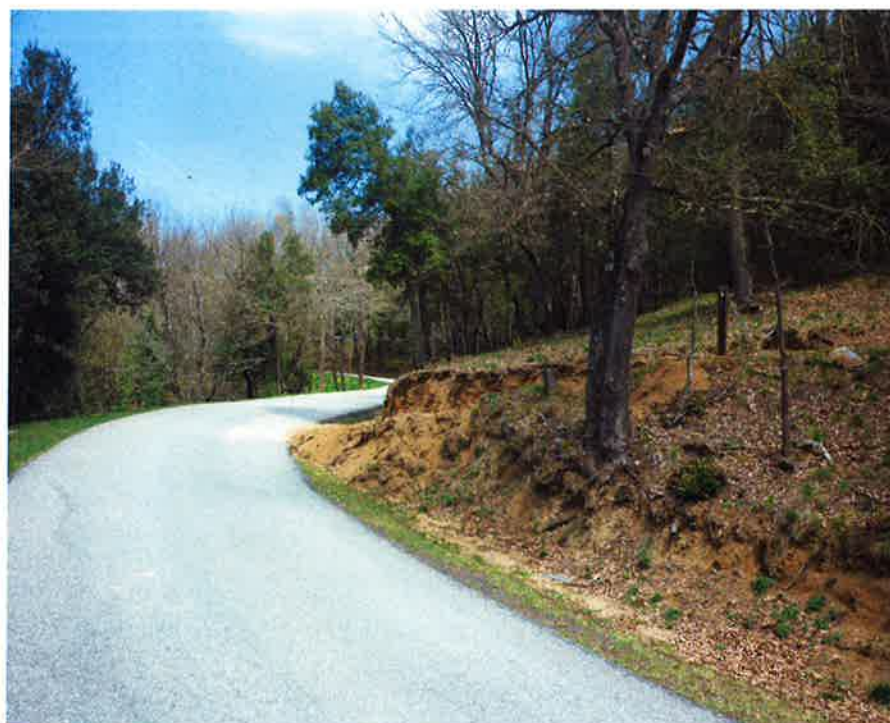
Foto número 6: Estat actual Carrer A direcció carretera Gi-520.
