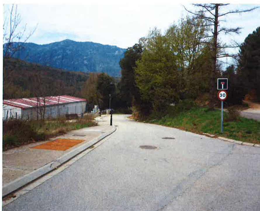
Foto número 14: Carrer de dalt existent on es construirà el cul de sac. Existència de pous de registres sota calçada tant d'aigües pluvials com residuals. A l'esquerra de la fotografia es pot observar la nau que cal respectar.
