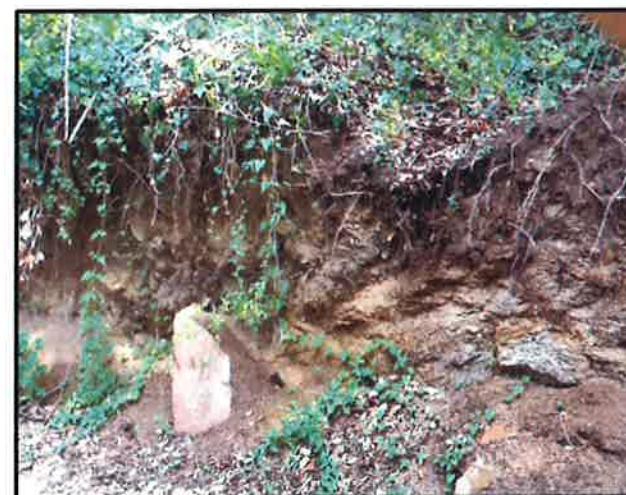
Detall del material en superfície en l'extrem est, amb un gruix important de sòl sorrenc, i amb surgències d'aigua.
