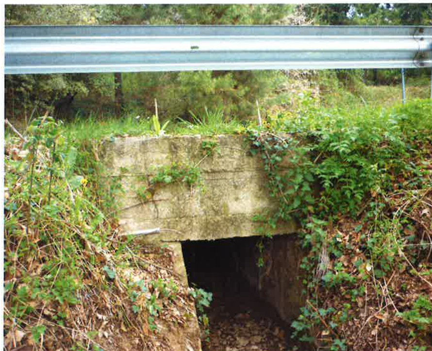
Foto número 17: Pas existent sota carretera GI-520 de secció rectangular.
