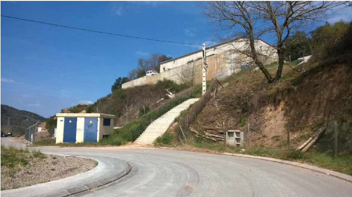
V4 – Rotonda i vial d'accés per a vianants que comunica amb el vial superior
