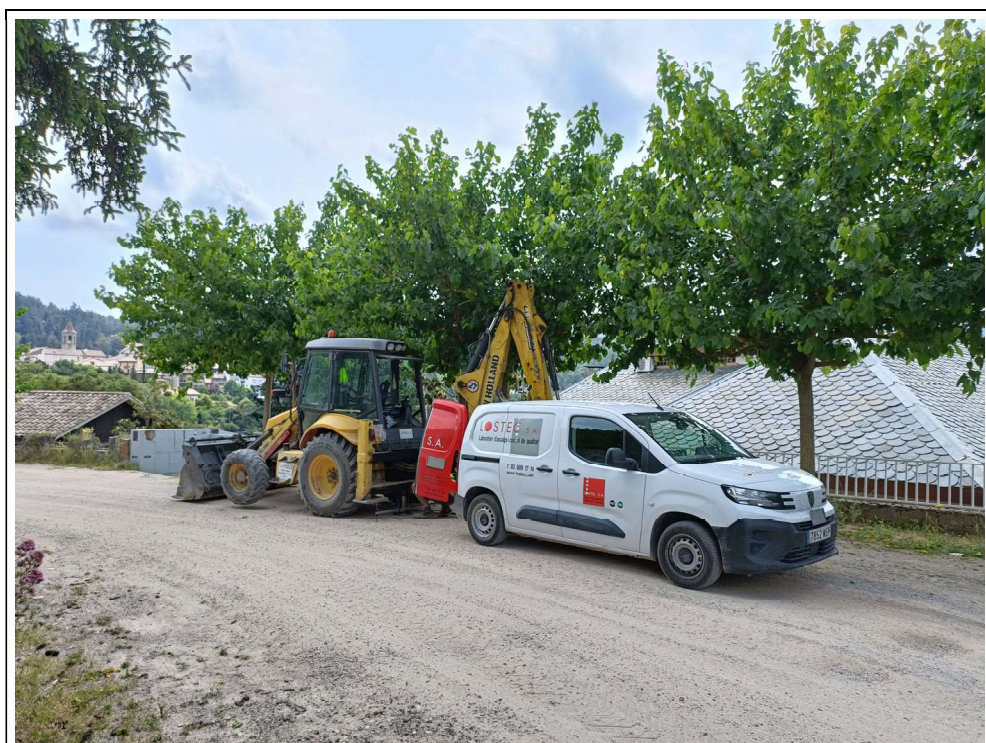
Fotografia de la ubicació de la placa de càrrega P5
