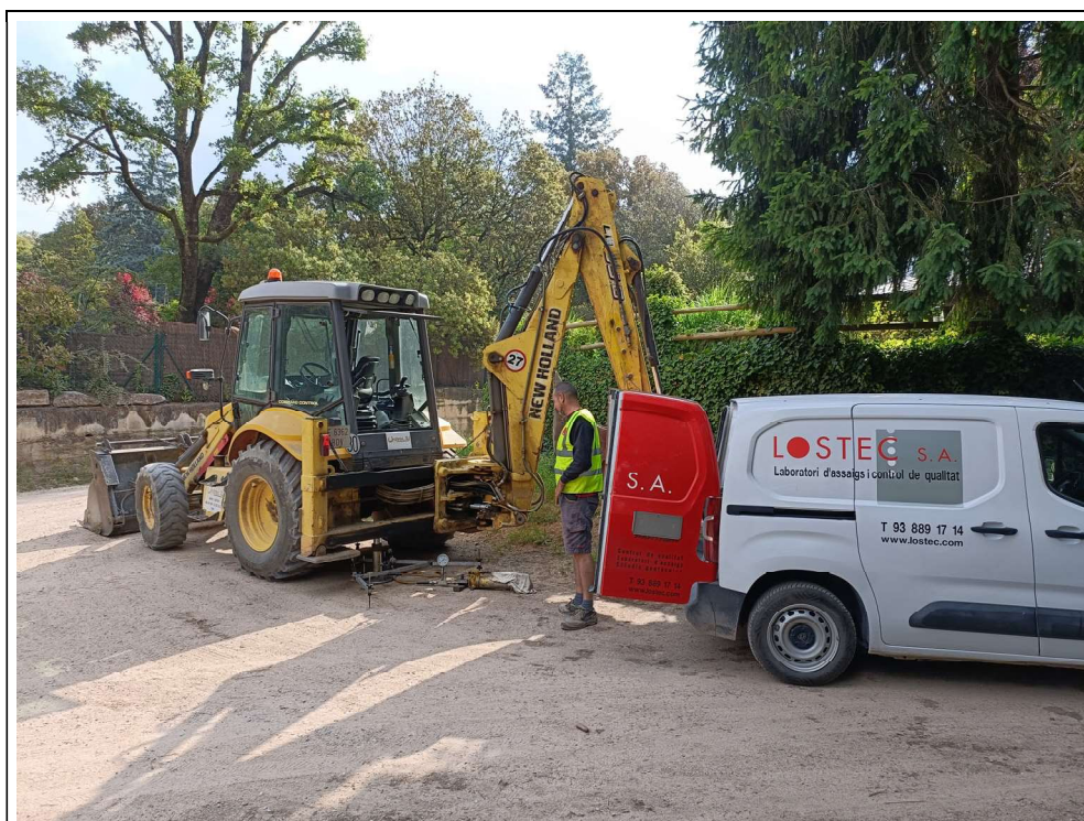
Fotografia de la ubicació de la placa de càrrega P3
