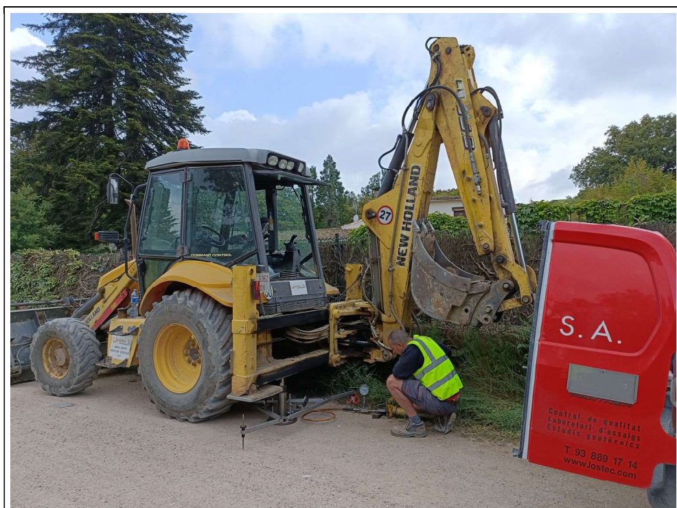
Fotografia de la ubicació de la placa de càrrega P2
