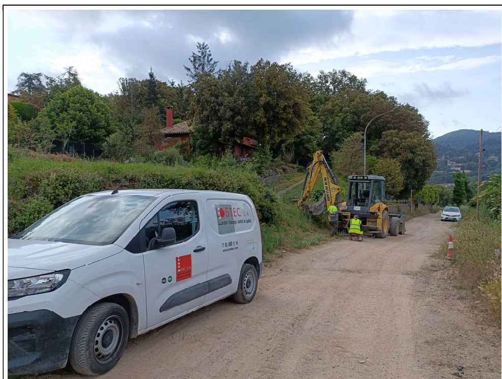
Fotografia de la ubicació de la placa de càrrega P1
