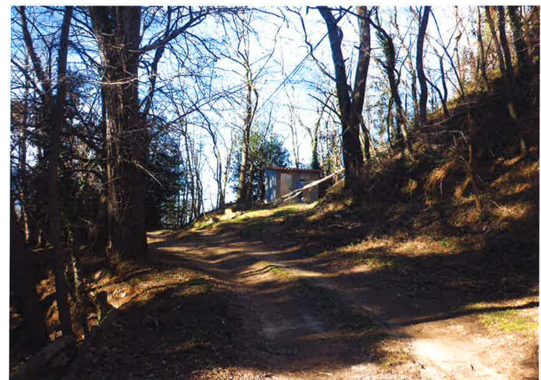
Foto número 8: Caseta de cloració, situada a la zona d'on sortirà la nova canonada.
