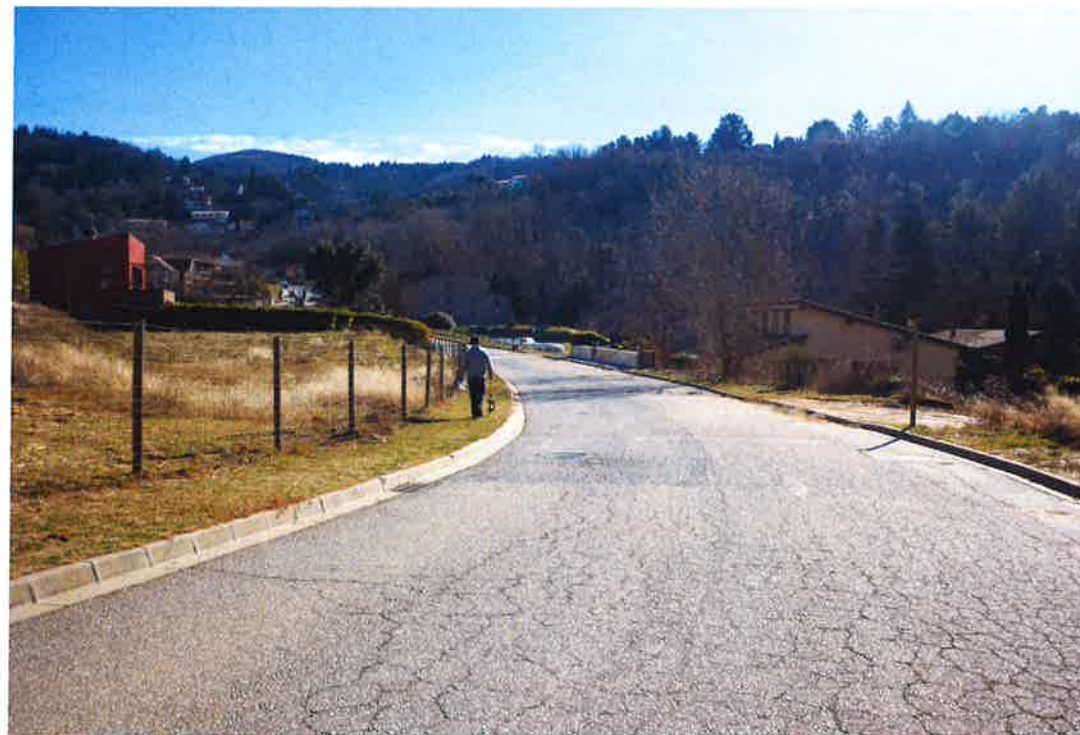
Foto número 2: Avinguda del Montseny. Calçada per sota la qual discorrerà la nova canonada de PE-125mm per l'abastament d'aigua potable a la nau de Lluçà Vegetals.
