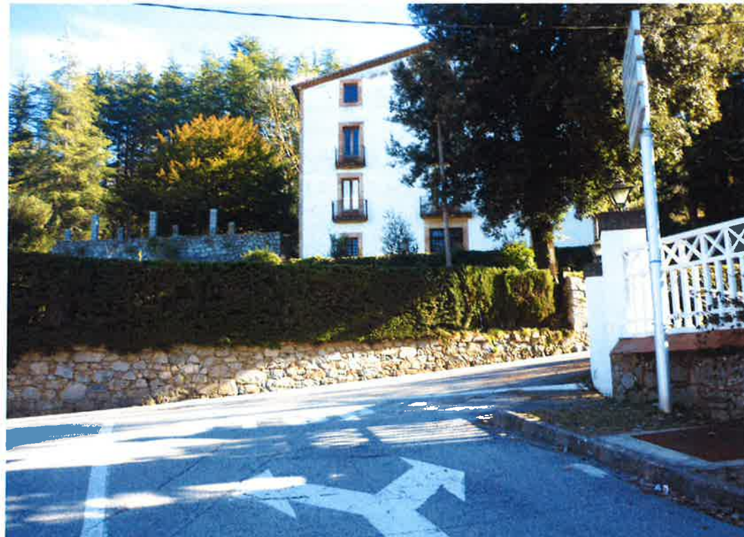
Foto número 5: Intersecció de l'Avinguda del Montseny amb el Passeig de Ramón Bofill. Aquí es realitzarà la connexió entre la nova canonada de fosa dúctil FD-150mm i la nova canonada de PE-125mm.
