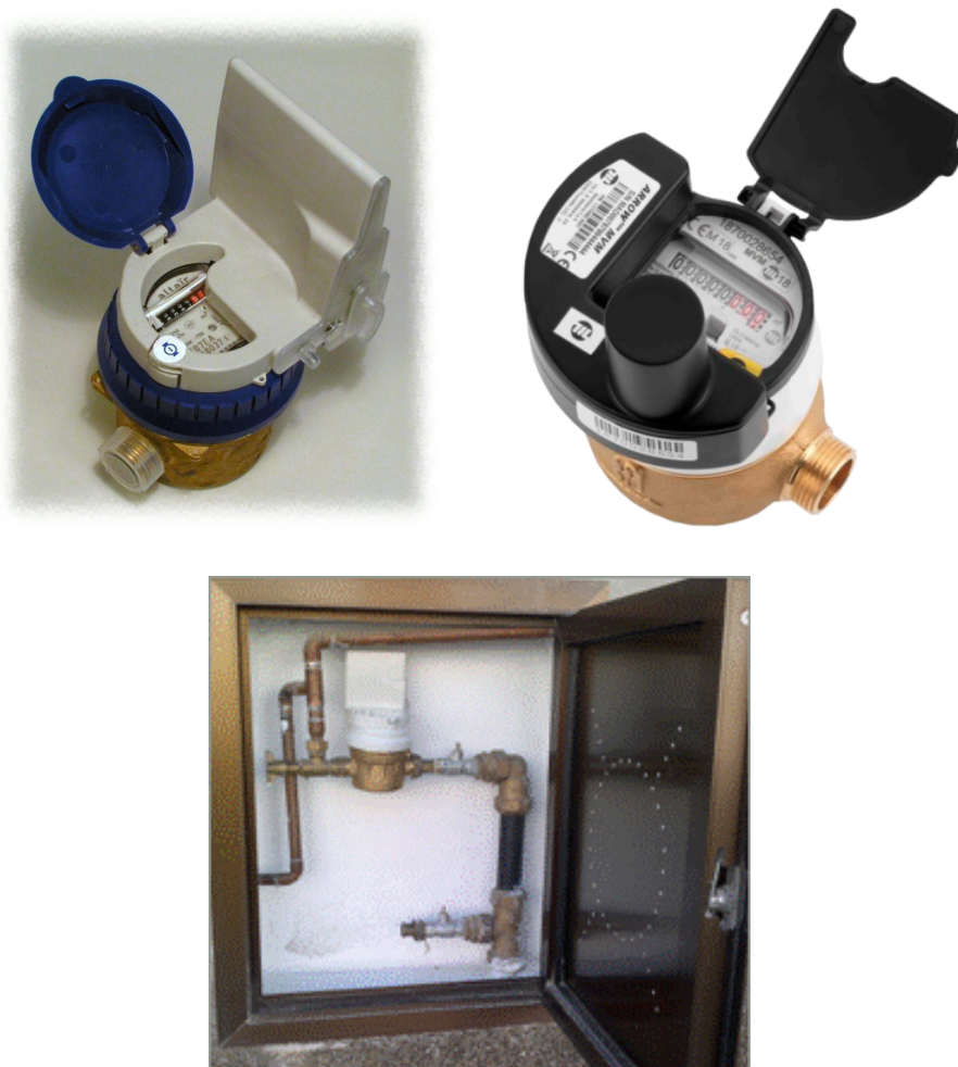
Exemples d'instal·lacions de comptador amb mòdul de teletectura incorporat
