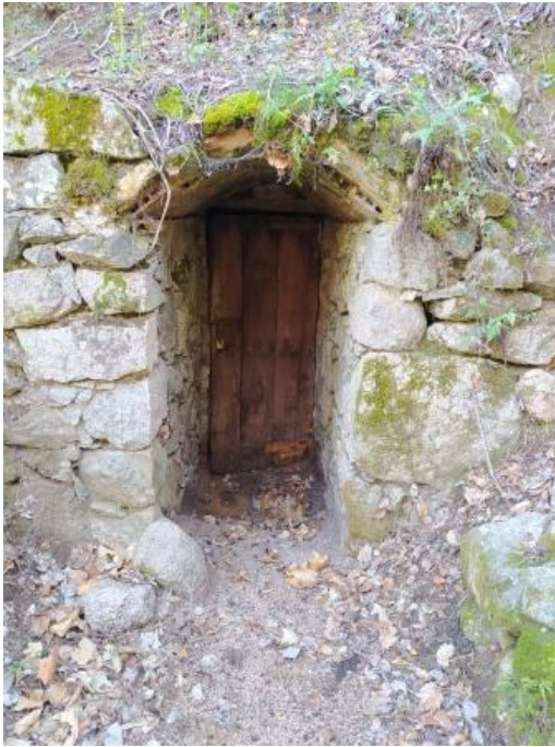
Fig. 55 – Porta exterior de la galeria G8
