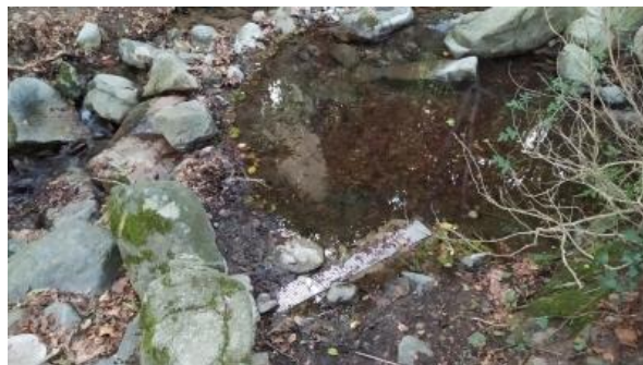
Fig.31 – Vista lateral captació A13
