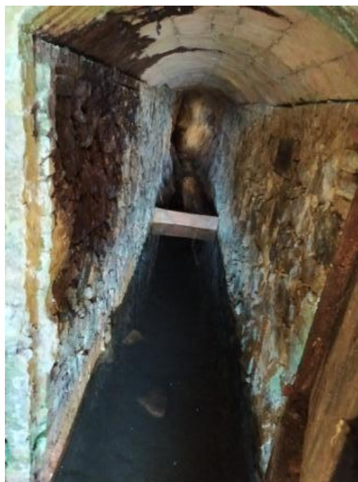
Fig.37 – Vista interior de la galeria G2
