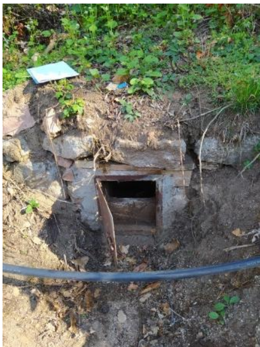
Fig.46 – Porta exterior de la galeria G4.1
