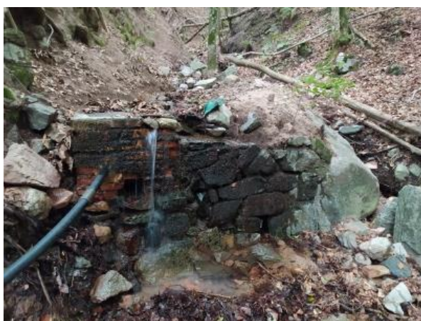
Fig.1 – Vista frontal captació A4.1
