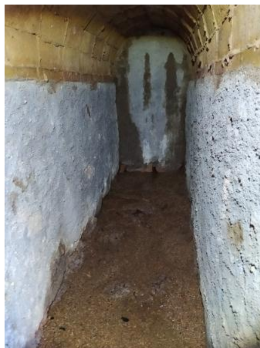
Fig. 63 – Paret final de la galeria
