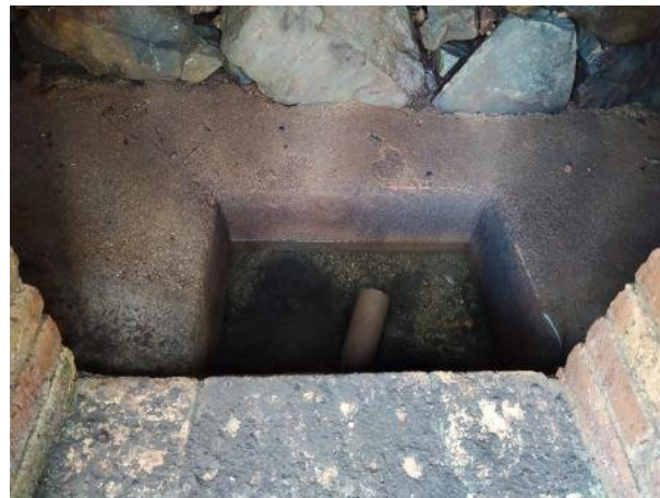
Fig. 75 – Arqueta de recollida d'aigua
