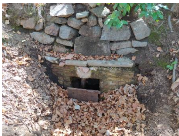
Fig. 68 – Porta exterior de la galeria G11
