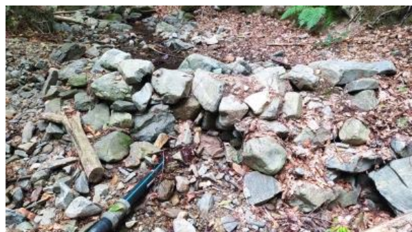
Fig.19 – Vista frontal captació A9.1
