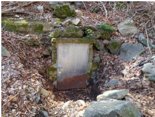
Fig. 74 – Porta exterior de la galeria G13
