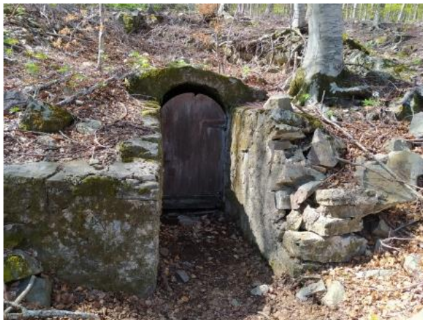
Fig.78 – Porta exterior de la galeria G14
