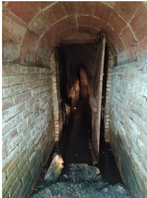
Fig. 43 – Porta exterior de la galeria G4.0
