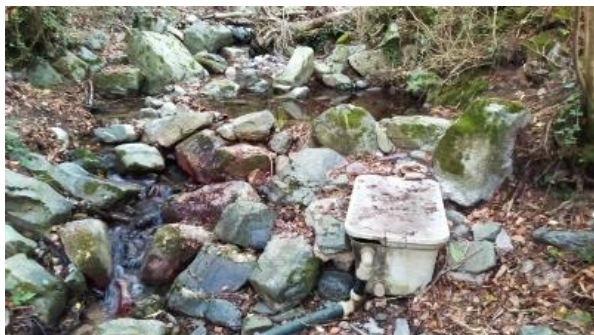
Fig.30 – Vista frontal captació A13
