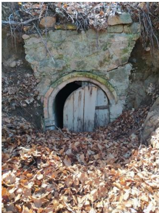
Fig. 66 – Porta exterior de la galeria G10
