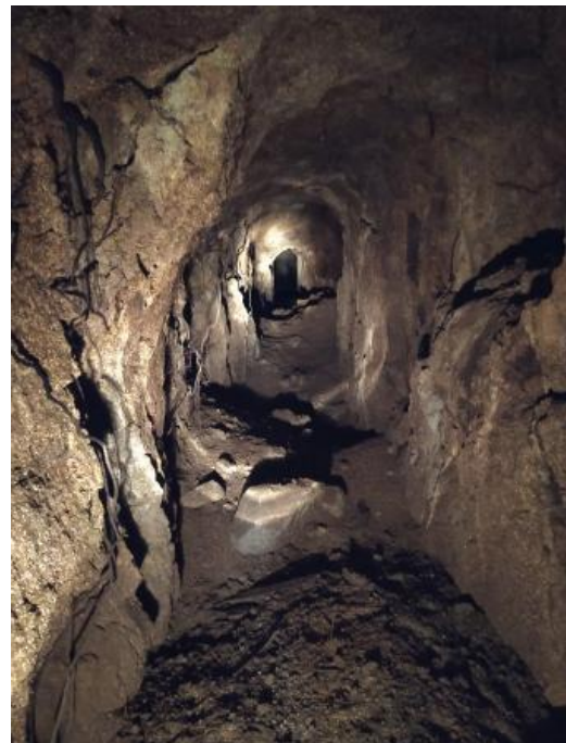
Fig. 41 – Vista interior de la galeria G3
