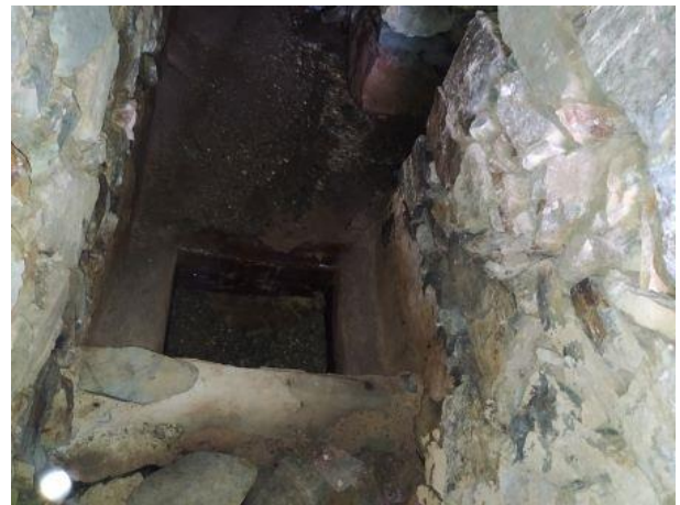
Fig. 79 – Arqueta de recollida d'aigua
