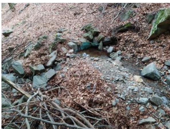
Fig.12 – Vista superior captació A7
