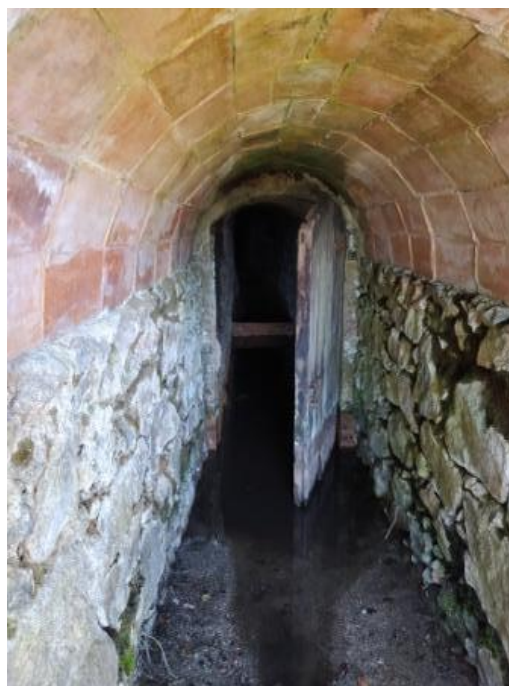
Fig.35 – Porta exterior de la galeria G2 oberta
