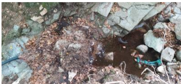
Fig.5 – Vista superior captació A5
