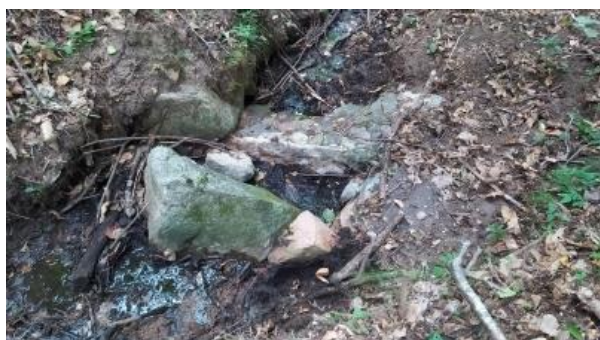
Fig.22 – Vista posterior captació A10
