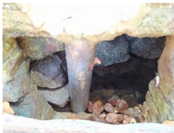
Fig. 69 – Vista interior de la galeria G11
