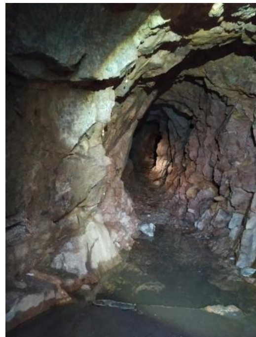
Fig. 54 – Vista interior de la galeria G7
