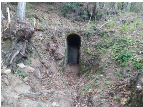
Fig.49 – Porta exterior de la galeria G5.0
