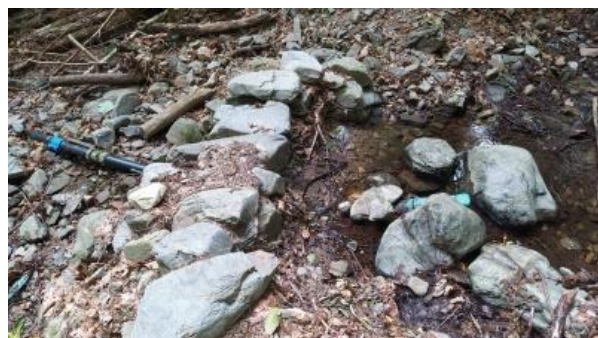
Fig.18 – Vista lateral captació A9.1
