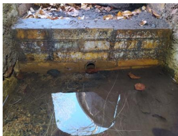
Fig. 65 – Vista entrada a galeria des de l'interior
