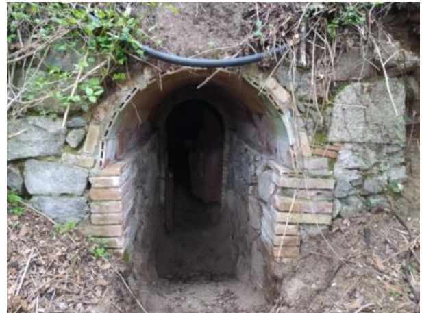
Fig. 39 – Porta exterior de la galeria G3
