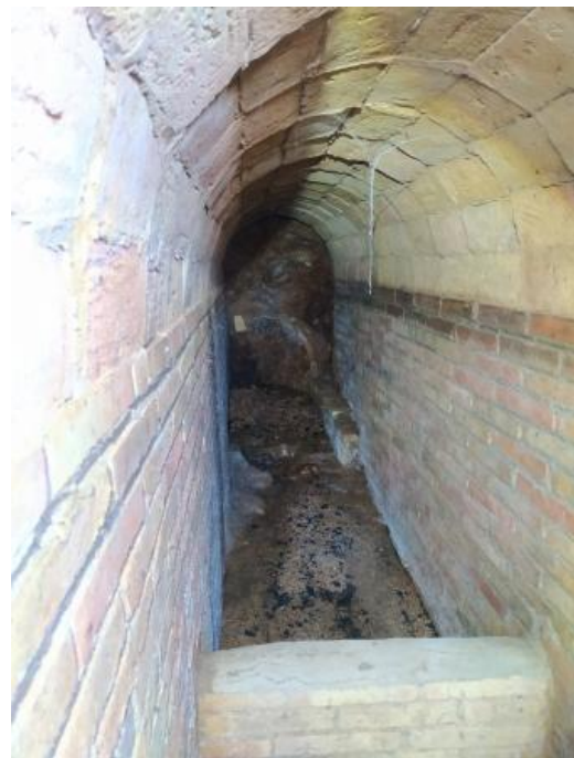
Fig. 67 – Vista interior de la galeria G10
