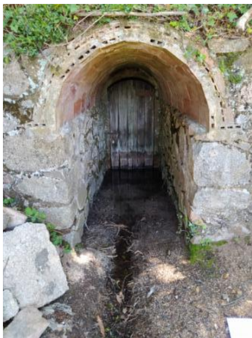
Fig.34 – Porta exterior de la galeria G2
