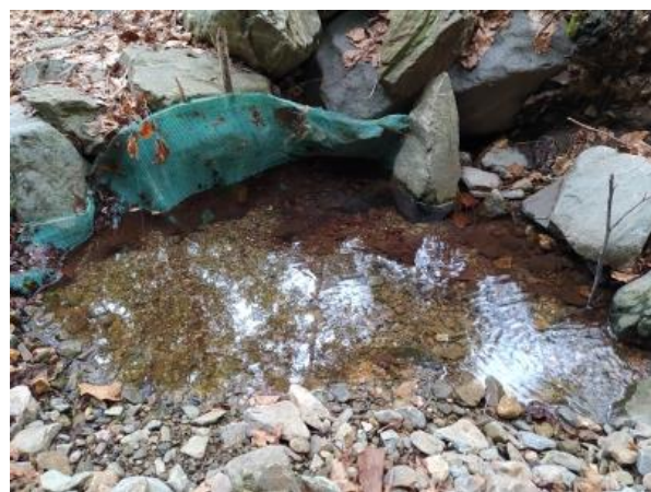
Fig.14 – Vista detall filtre captació A7
