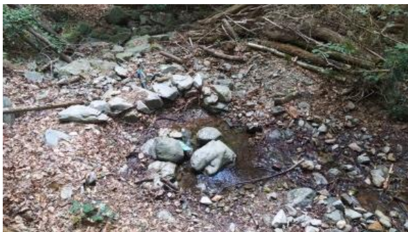
Fig.16 – Vista superior captació A9.1
