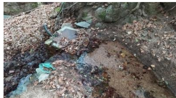
Fig.4 – Vista superior captació A4.1
