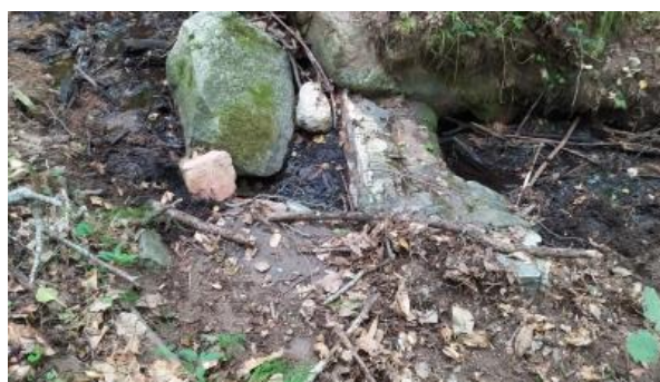
Fig.21 – Vista lateral captació A10
