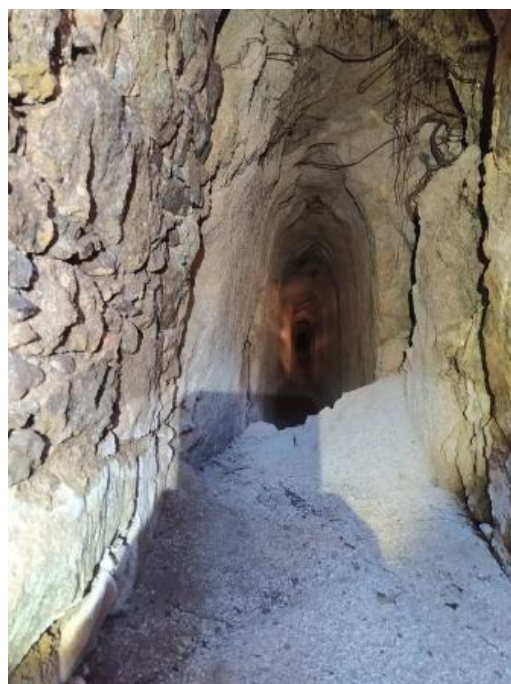
Fig. 84 – Vista interior fons de la galeria G15
