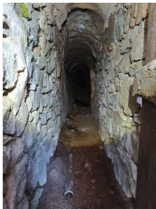
Fig. 52 – Vista interior de la galeria G6
