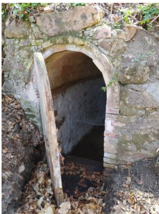
Fig.62 – Porta exterior de la galeria G9 oberta
