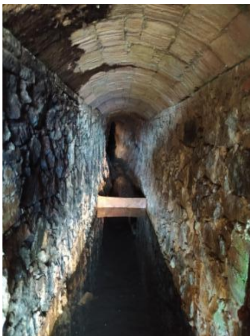
Fig.36 – Vista interior de la galeria G2
