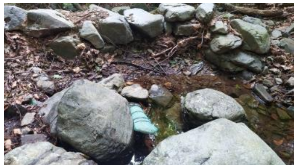
Fig.17 – Vista posterior captació A9.1
