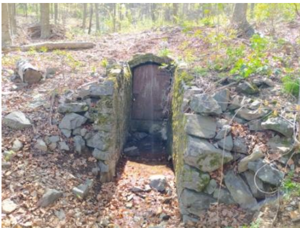
Fig.70 – Porta exterior de la galeria G12
