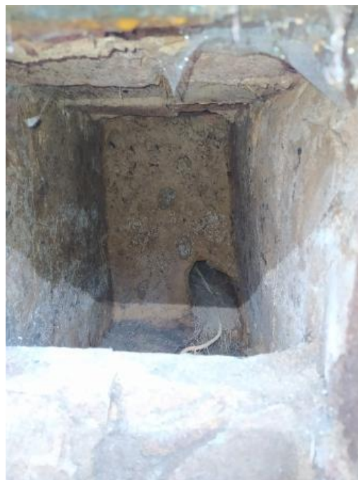
Fig.47 – Vista interior de la galeria G4.1
