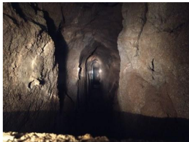
Fig.50 – Vista interior de la galeria G5.0
