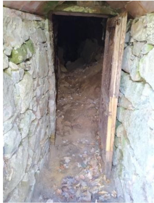
Fig. 56 – Porta exterior de la galeria G8 oberta
