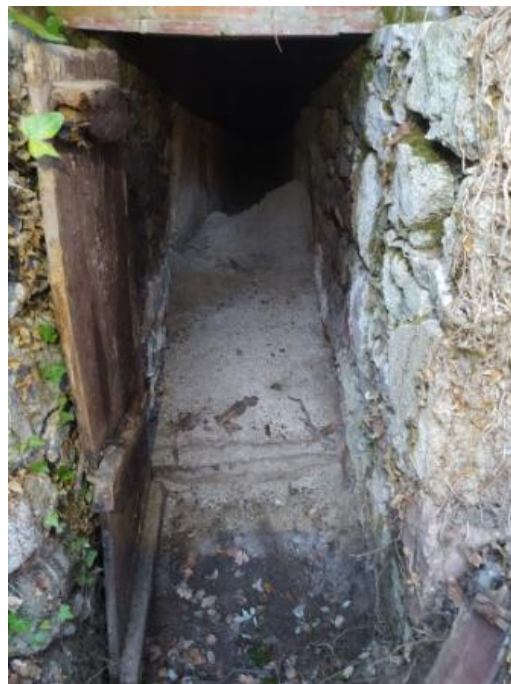
Fig.82 – Porta exterior de la galeria G15 oberta
