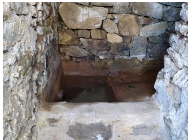
Fig. 71 – Arqueta de recollida d'aigua
