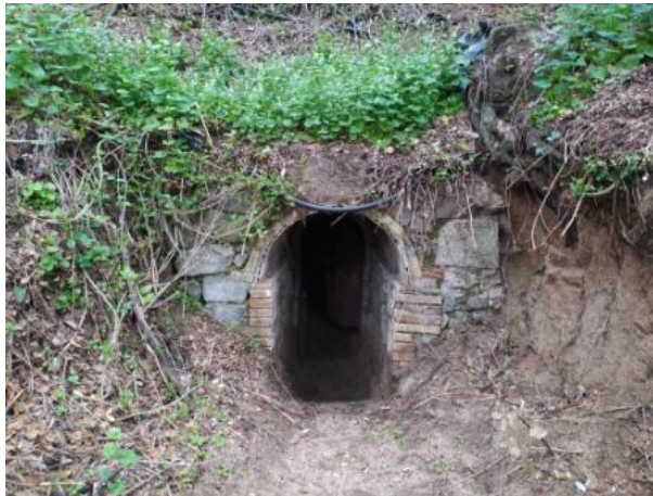
Fig.38 – Vista exterior de la galeria G3
