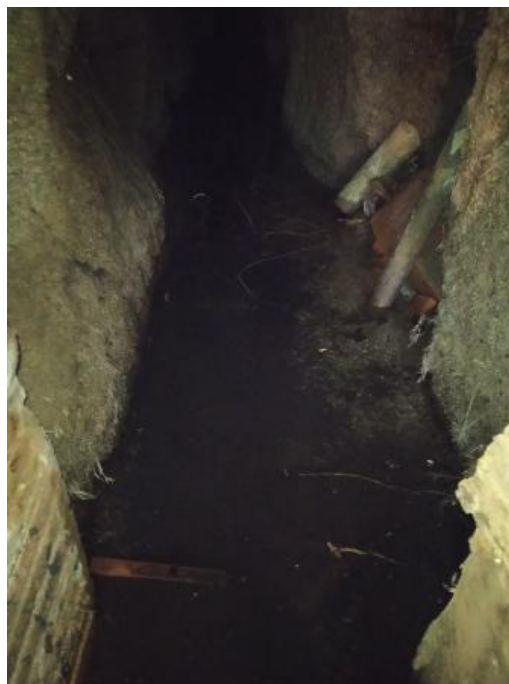
Fig. 45 – Vista interior de la galeria G4.0
