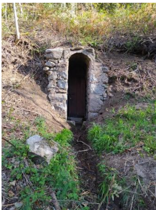
Fig. 51 – Porta exterior de la galeria G6
