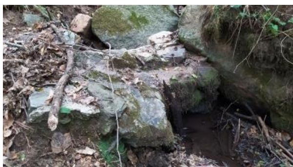
Fig.20 – Vista frontal captació A10
