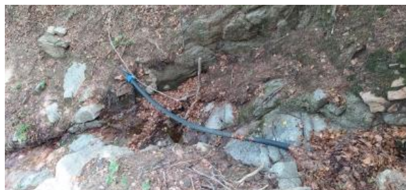
Fig.6 – Vista general captació i arqueta
