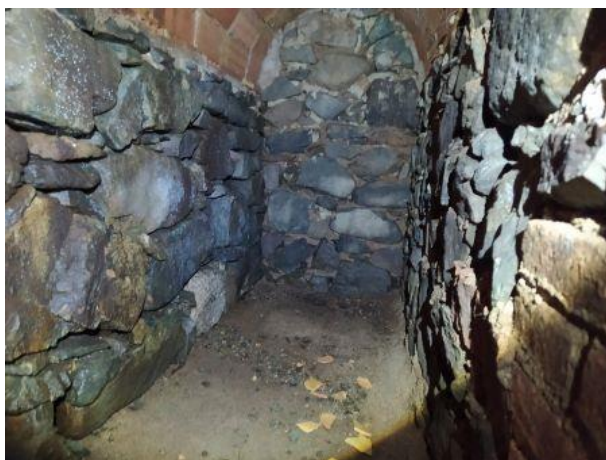
Fig. 76 – Vista interior dreta de la galeria
