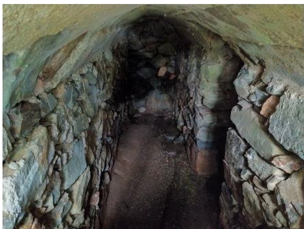
Fig. 80 – Vista interior dreta de la galeria
