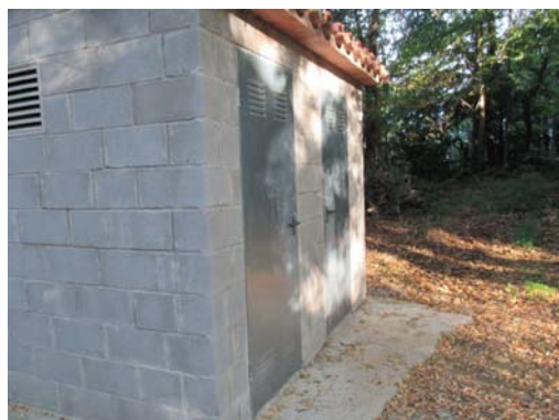
Caseta de cloració actual
