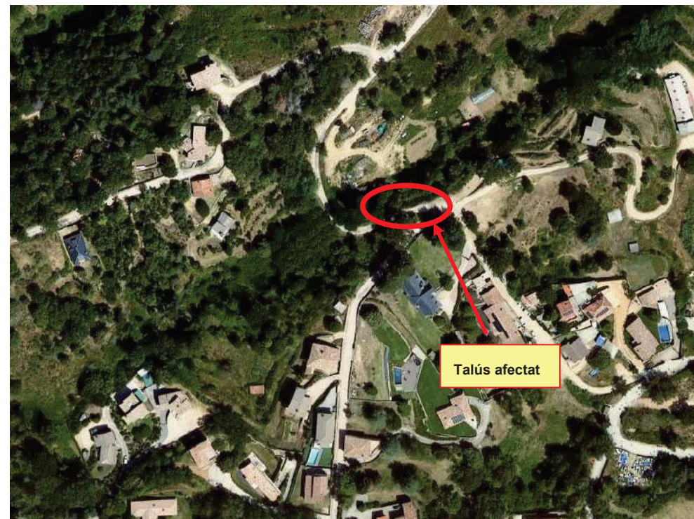
Imatge 1.- Situació del Talús afectat.
