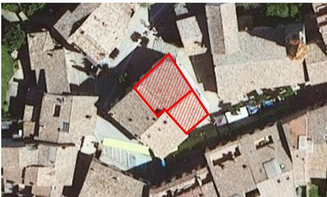
Figura.2 Part de la coberta utilitzada per la instal·lació dels panells fotovoltaics
