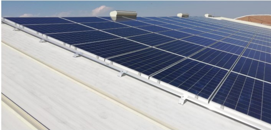
Figures.6. Imatges del suport de Bultmeier tipus coplanar
