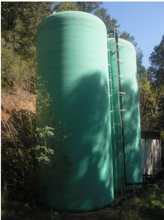
Dipòsits d'H 2 O existents.
