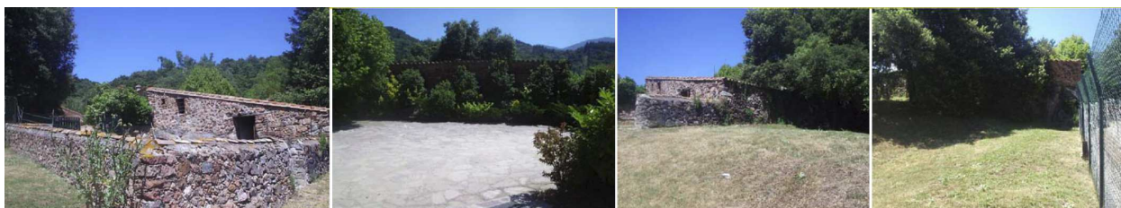
Edificació 6: Edificació auxiliar: corral.
