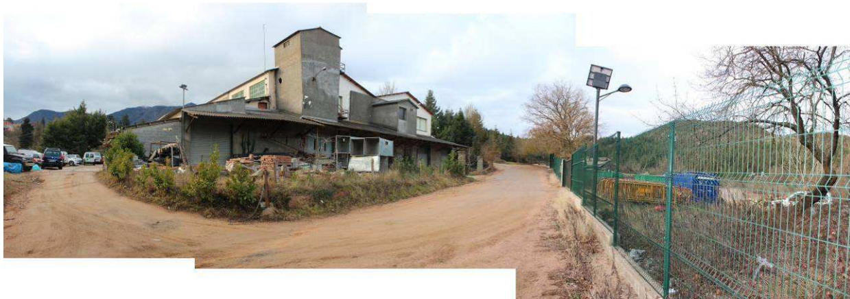
Passeig Guilleries cap a ponent, amb la zona de l'antic abocador (actual àrea d'aportació) al costa nord (dret).
