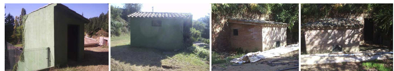
Edificacions 10,12,13: Pavelló estiu, piscina, pista de tennis, recinte instal·lacions i magatzem
