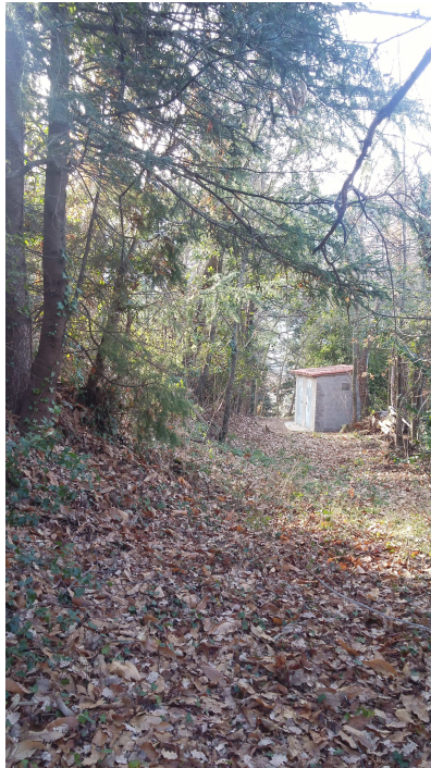
Cambra actual de cloració i distribució; la instal·lació de la nova ETAP i dipòsit s'encastaran al marge.
