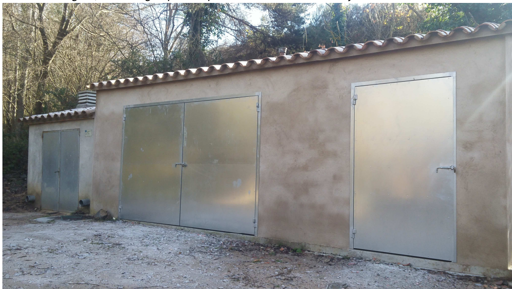
Instal·lació de les bombes d'impulsió de la bassa de Puigdot (encastada al peu del marge nord-oest de la bassa)
