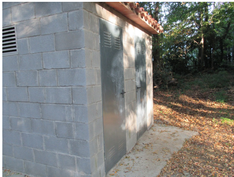
Imatge 9.- Caseta de cloració actual
