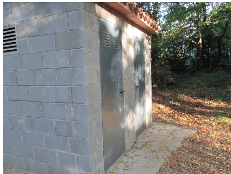
Foto 2. Caseta de cloració actual
