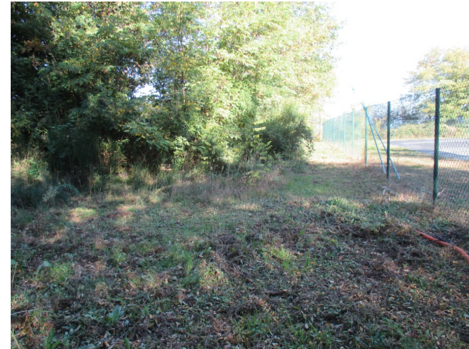
Imatge 10.- Lateral oest de la tanca perimetral de la bassa
