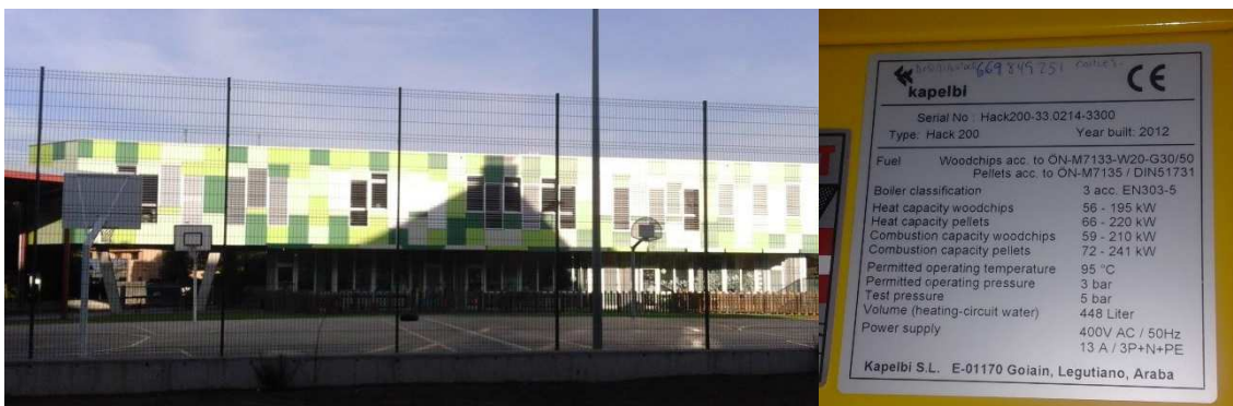
Escola i placa de la caldera de biomassa
